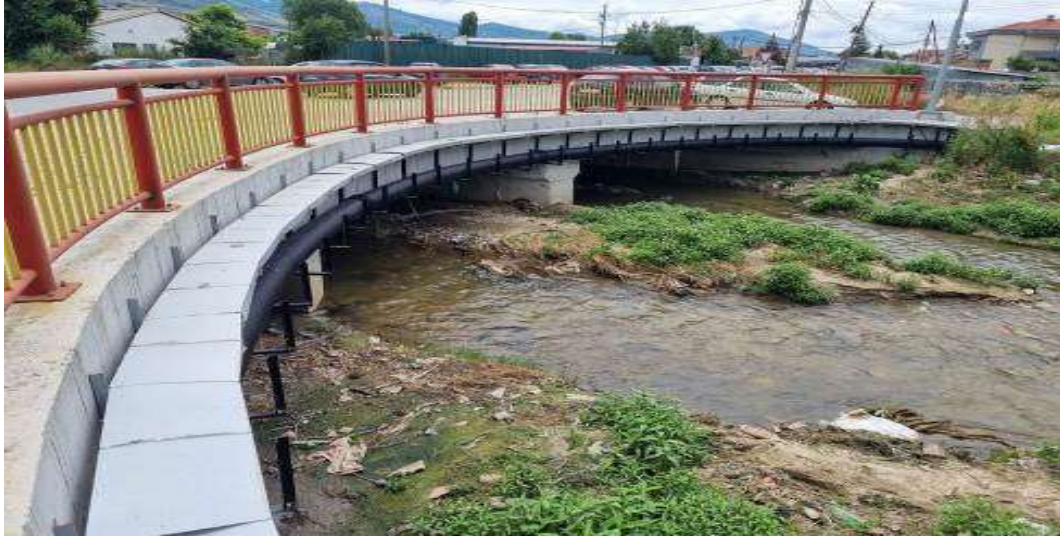
Мост на градска река на улица „Трајко Николоски“
