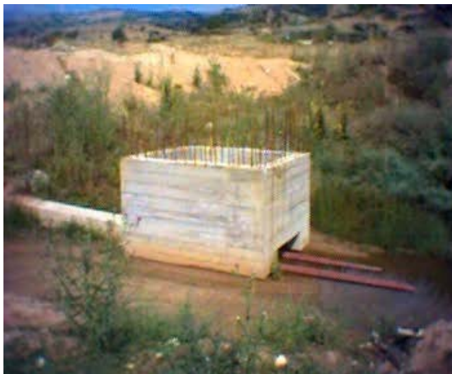
Фотографија 2-Одводна бетонска шахта
