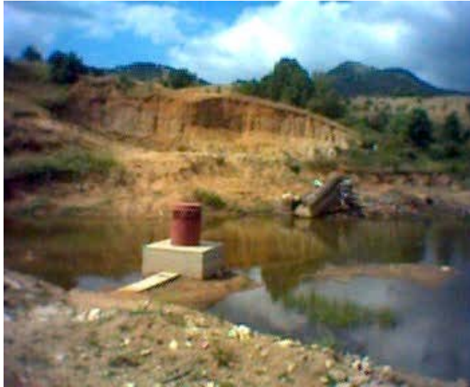
Фотографија 1-Бетонска преливна шахта
