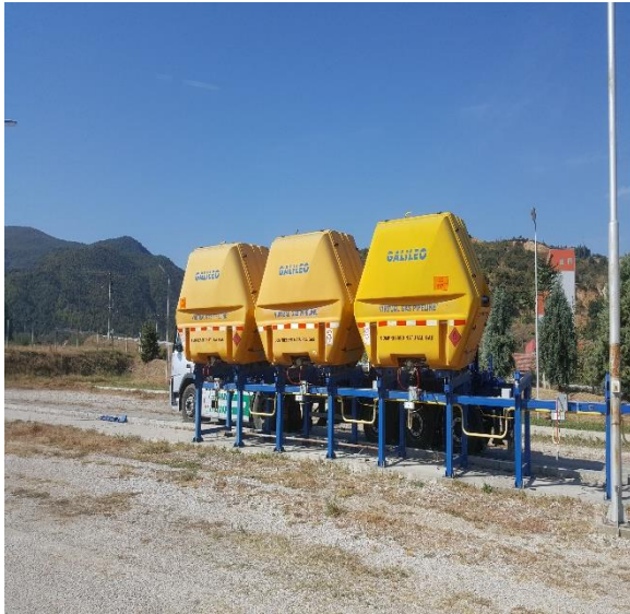
Декомпресиска станица за копресирање на природен гас во ЈП Струмица Гас.
