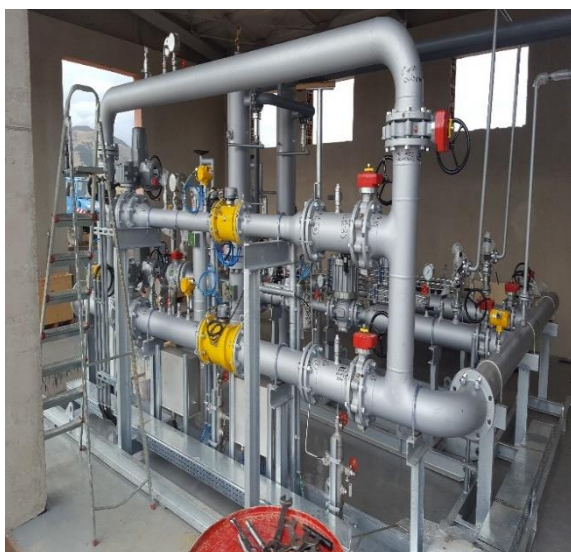
Изградба на главна мерна регулациона станица – ГМРС Штип и Блок станица
