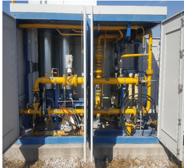
Декомпресиска станица за копресирање на природен гас во ЈП Струмица Гас.
