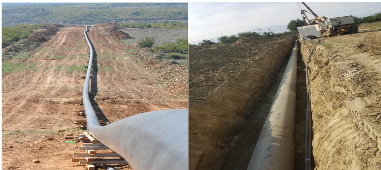
Изградба на магистрална гасоводна делница (линиски дел)
